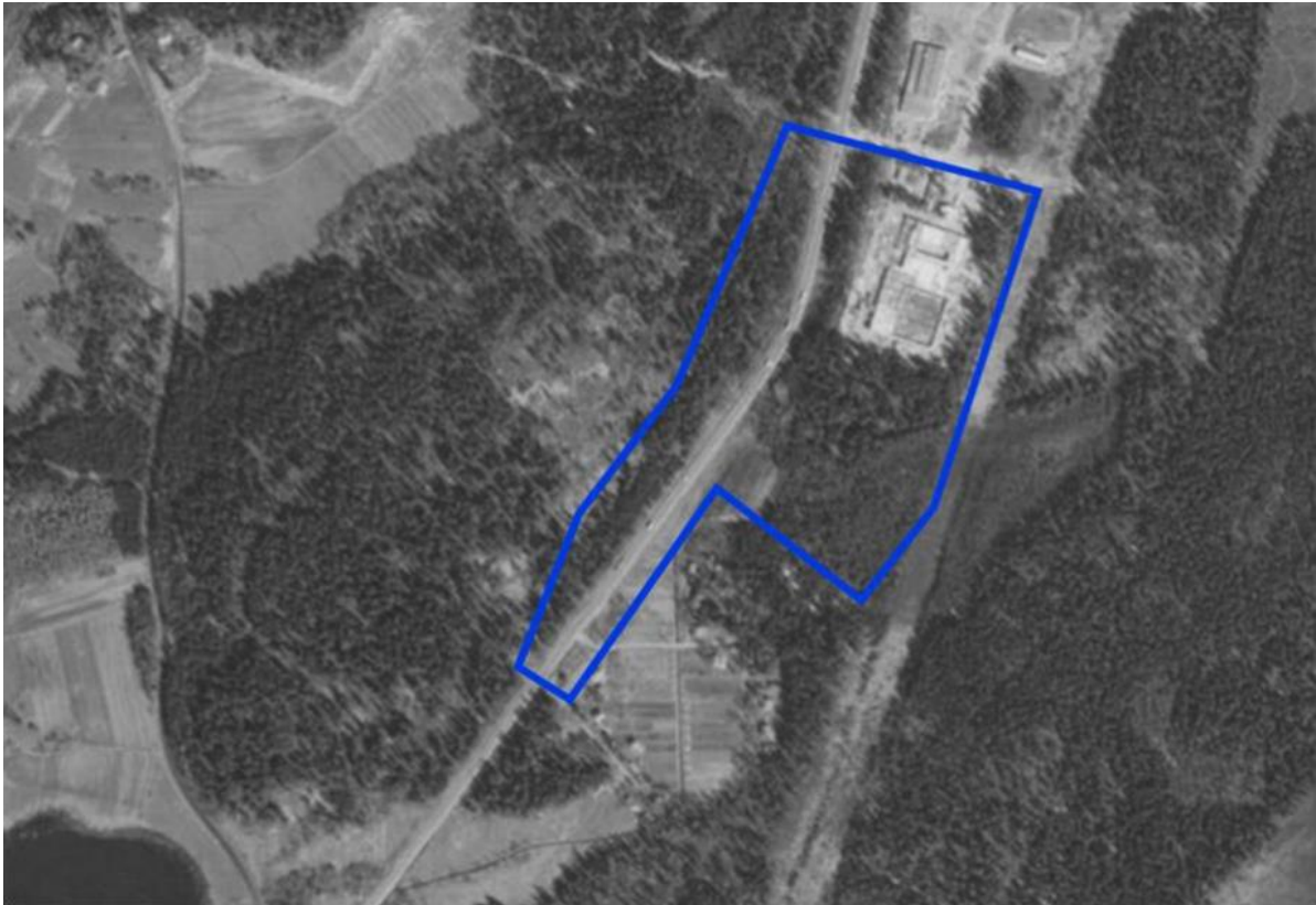
Kuva 4. Ilmakuva Peltolammin alueesta vuodelta 1966. Karkea rajaus kohteesta sinisellä. Entinen Valion kiinteistö on osin rakennettu / rakenteilla (Lähde: Vahanen, 2021.)
