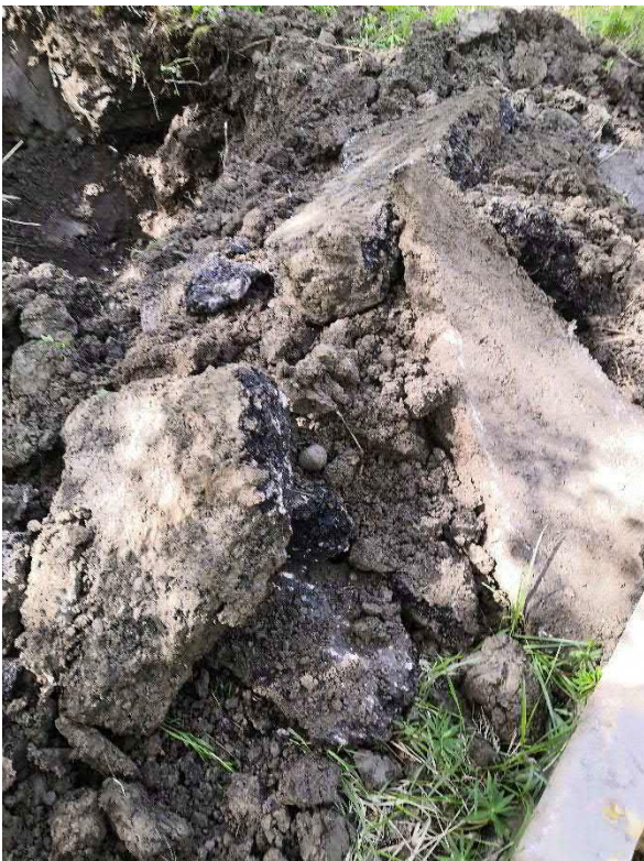
Kuva 17. Koekuopan VAH15 kaivumassoja, jossa asfaltinkappaleita.
