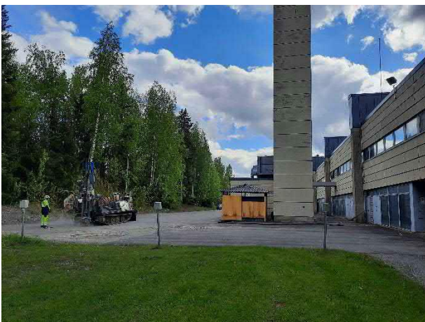
Kuva 22. Tutkimuspiste VAH26, vanha lämpökeskus sekä betonibunkkeri asfalttialueella.
